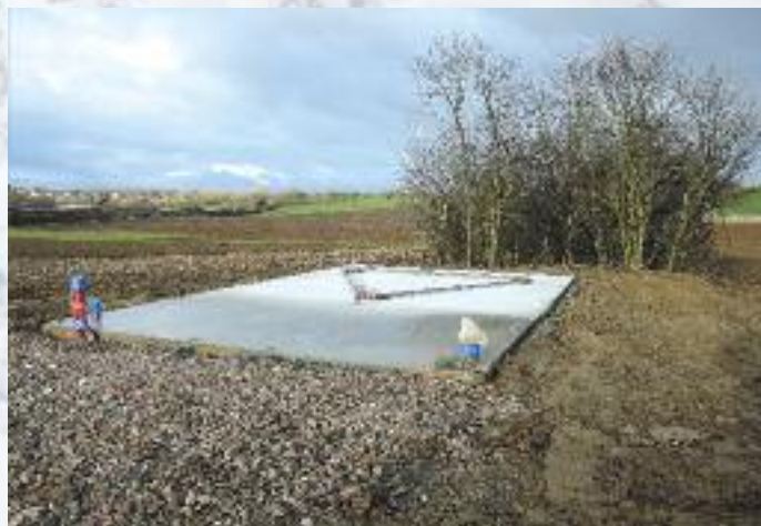
Plate-forme de la future antenne
