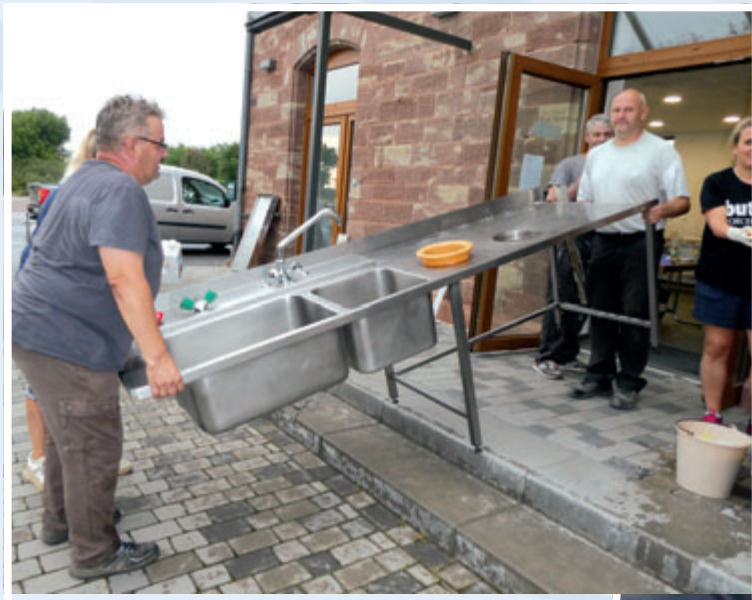
Travaux d'aménagement de la cuisine à la salle polyvalente
